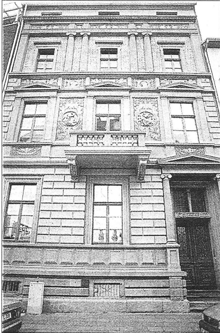
DIE SCHMUCKVOLLE FASSADE ist wiederhergestellt, dank der Initiative des neuen Besitzers. (Bild: Rakoczy)
